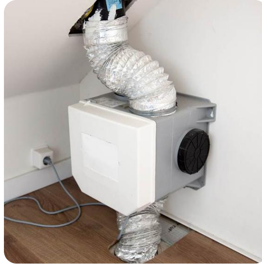
Mechanische ventilatie
